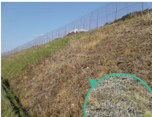
草刈機の作業が困難な傾斜地でバスタの効果試験を実施しました。「傾斜地を崩さない」ことも実証されました。
